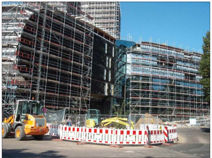
Abbildung 1: Deutsche Nationalbibliothek Leipzig - vierter Erweiterungsbau mit Büchertürmen im Hintergrund, im Vordergrund Verlegung der Anbindungsleitungen des Sondenfeldes (Foto: A. Behnke, HGC Hydro-Geo-Consult GmbH)
